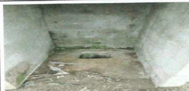
Foto 6: Instalacion de inodoros de plastico
