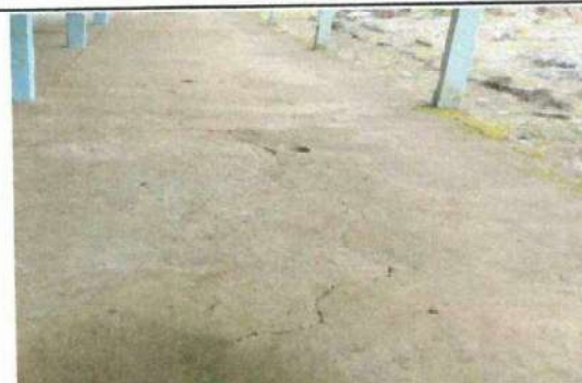
Foto 4: Colocacion de barandas
