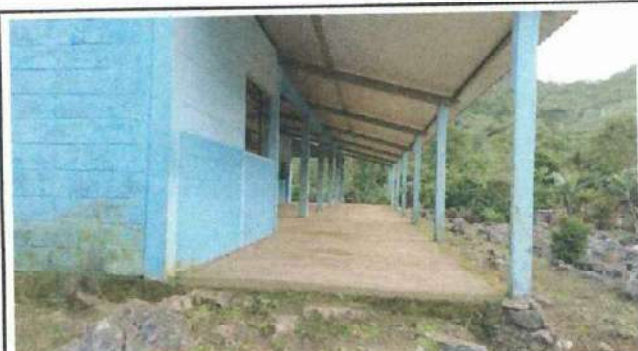
Foto3: Colocacion de barandas
