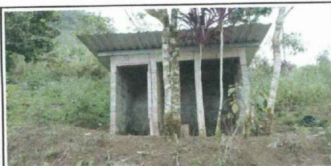
Foto 5: Intalacion de puertas de Sanitarios
