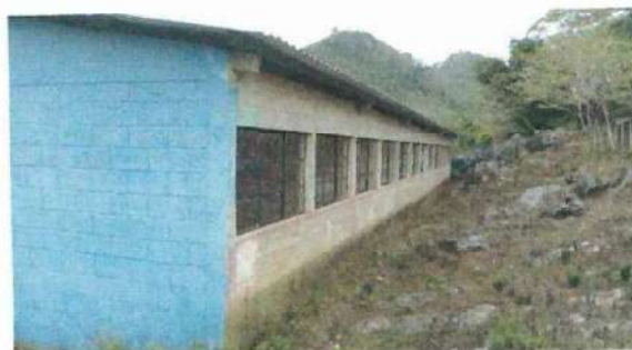
Foto 2: Colocacion de canales y bajadas de agua pluvial
